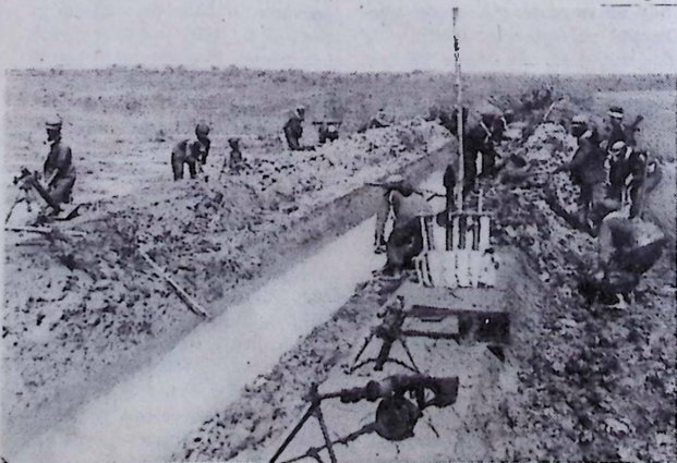
Soldaterne fra befrielseshæren deltog, både under og efter i opbygningen af landet. Her graver en deling en overrislingskanal.
